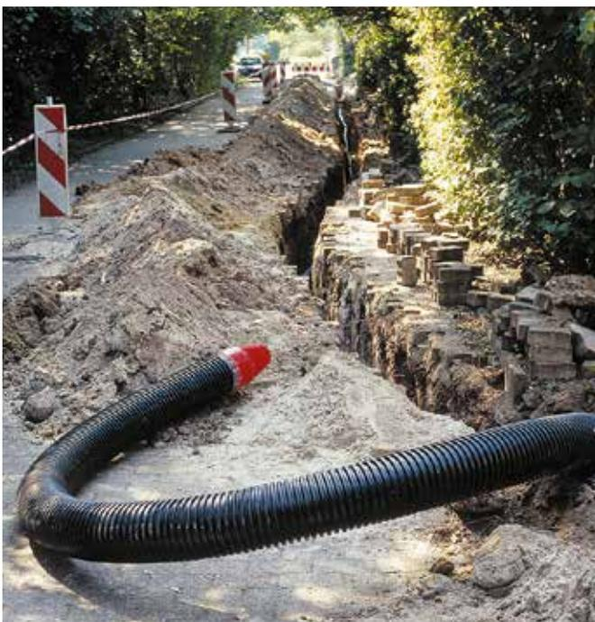
El material de relleno debe compactarse por capas; a partir de una capa de 500 mm debe realizarse también de forma mecánica. A continuación, se coloca la cinta de señalización y se rellena la zanja.
