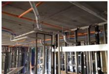
En comparación con los sistemas de tuberías de cobre, [la calefacción hidrónica] presenta un menor costo de materiales, ahorros en la mano de obra, espaciamiento similar entre los soportes colgantes, un sistema de ajuste más confiable, velocidades de flujo más altas y menos ruido.
