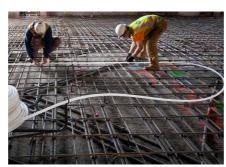
No podíamos aislar el primer piso en las zonas de las clavijas, por lo que terminamos con este diseño cuadriculado de revestimiento de aislamiento rígido de dos pulgadas que cubría casi del 50 al 60 % de la zona. No era para nada fácil para los instaladores caminar sobre este diseño cuadriculado, ni hablar de trabajar sobre este, y eso hizo que se necesitara más tiempo de instalación.
