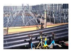
La ligereza de las tuberías PEX hizo que fuera más fácil moverse en el lugar de trabajo, y su extrema flexibilidad hizo que su instalación fuera fácil y rápida alrededor de las barras de refuerzo en la base de la estructura.
