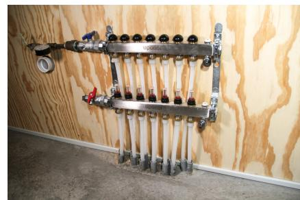
Además de permitir una mayor velocidad de flujo en comparación con el CPVC o el cobre, un sistema de PEX retiene un menor volumen de agua que un sistema del mismo tamaño usando cualquiera de esos materiales y con los mismos diámetros de tubería.
