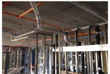
Par rapport aux réseaux de tuyauterie en cuivre, [chauffage hydronique] présente un coût de matériel réduit, des économies de main-d'œuvre, un espacement de suspension similaire, un système de raccords plus fiable, des vitesses de débit plus élevés et moins de bruit.
