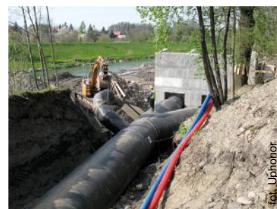
Budowa rurociągów derywacyjnych dla małej elektrowni wodnej na rzece Olzie
