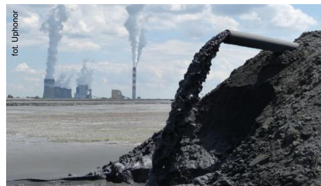
Hydrotransport popiołów rurami WehoSlurry na składowisku Bagno Lubień Elektrowni Bełchatów
