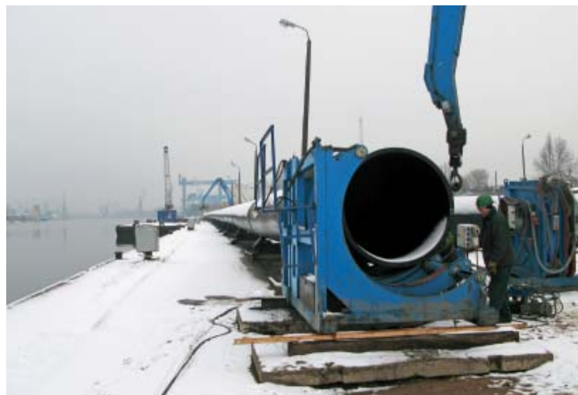
Fot. 5. | Zgrzewanie doczółowe rur w trudnych warunkach zimowych
