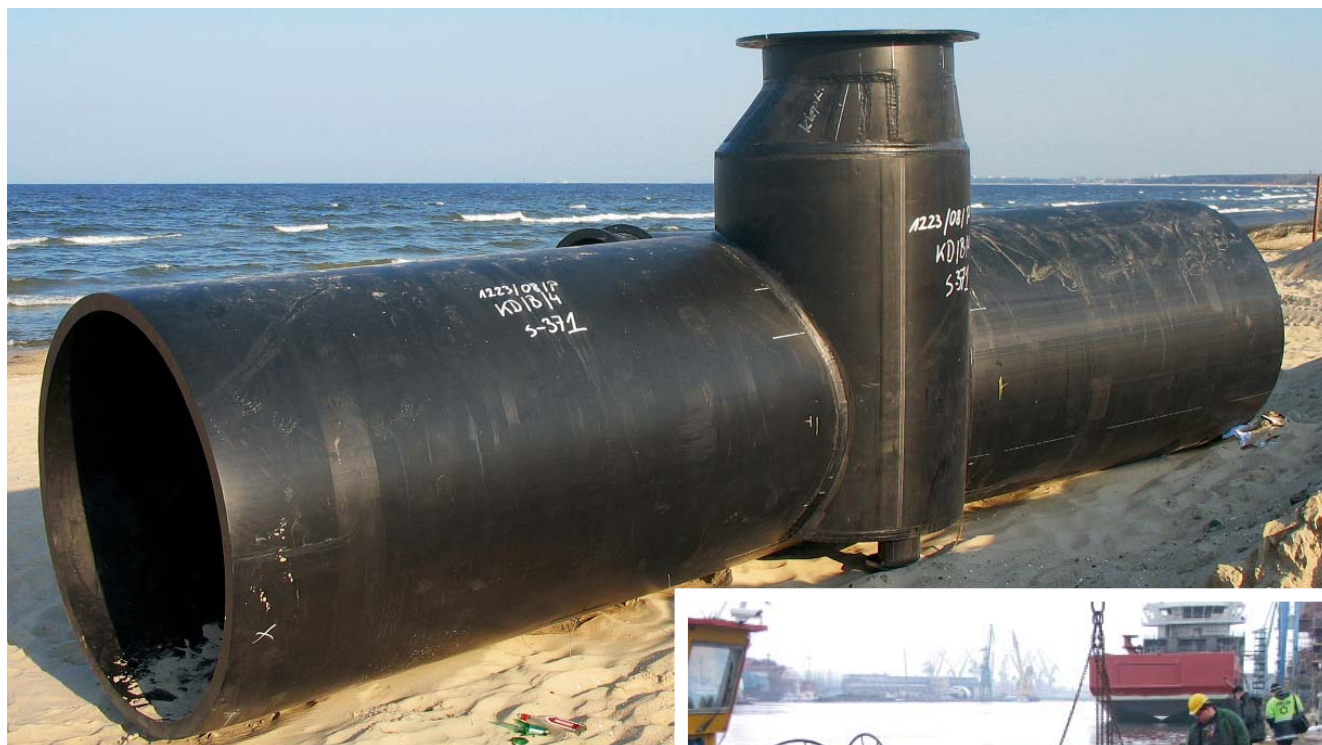
Fot. 4. | Studnia rewizyjna na kolektorze DN1400
