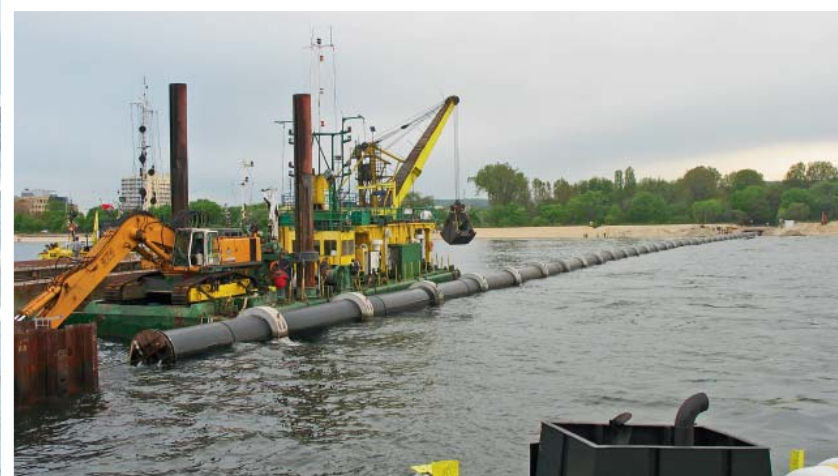
Fot. 2. | Zatapiając rurociągów zrzutowych
