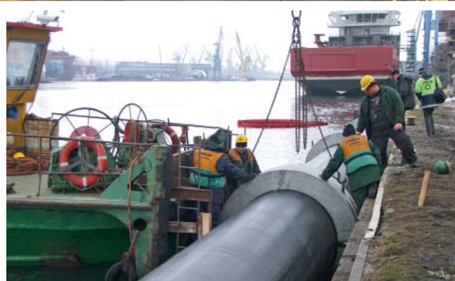
Fot. 6. | Zakładanie obciążników żelbetowych
