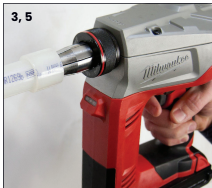
Figure 3-8 : Dilatation avec l'outil ProPEX Milwaukee M18
