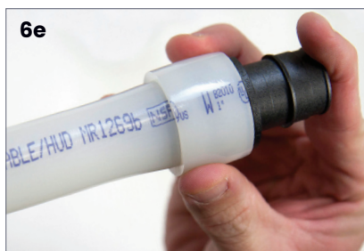
Figure 3-5 : Raccord ProPEX inséré dans un tuyau PEX de 1"
