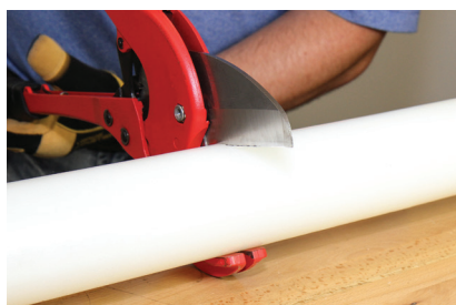
Figure 3-13 : Couper le tuyau
