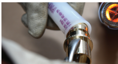
Figure 3-25 : Tourner le tuyau de droite à gauche
