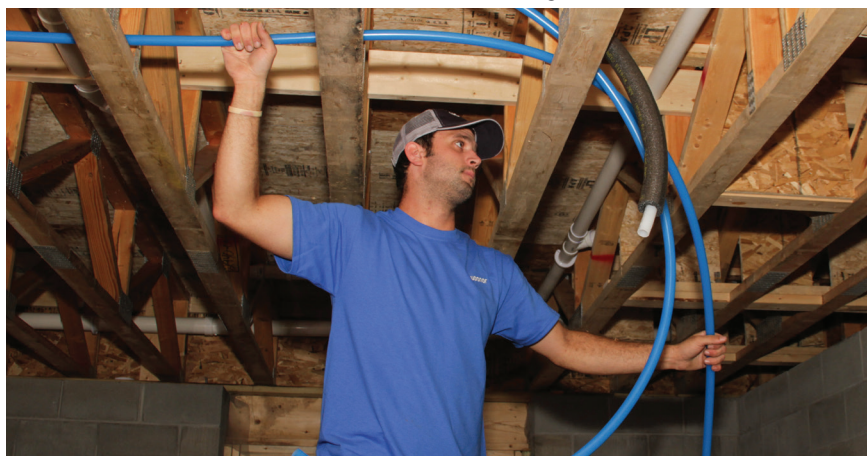
Figure 6-1 : Installation de canalisations Uponor AquaPEX dans des poutrelles ajourées
