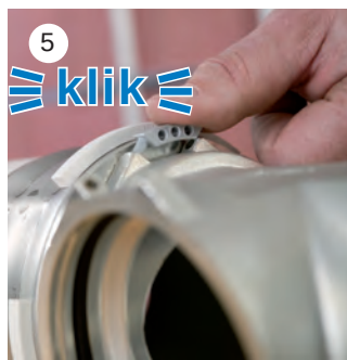
Kuva 1. Asenna viistetty komposiittiputki Uponor RS-liitinjärjestelmän puristuspäähän.
