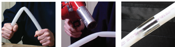
Figure 32 : Reformer un tuyau déformé
