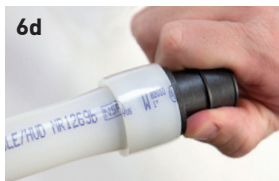
Figure 27 : Raccord ProPEX inséré dans un tuyau en PEX de 1"
