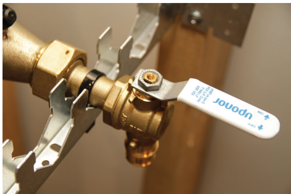
Figure 19 : Robinet en coude ProPEX en laiton sans plomb pour compteur d'eau
