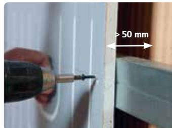
Esempio: sottostruttura con profili metallici CD 27/60
