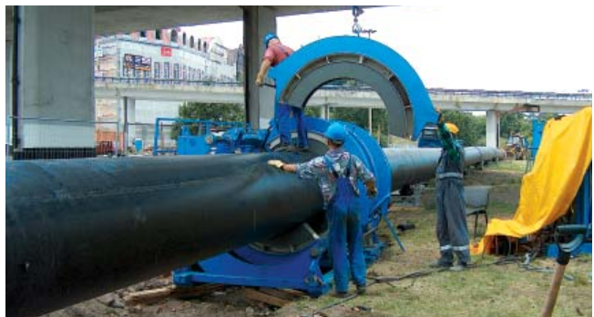
Fot. 5. Zgrzewanie pierwszej nitki rury PE 1033 pod Trasą Zamkową.
