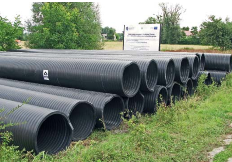
Fot. 3. Rury polietylenowe Weholite DN800 w 12.5 m. odcinkach przygotowane do montażu
