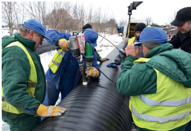
Fot. 4. Szkolenie na budowie w zakresie spawania ekstruzyjnego
