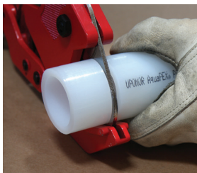
Figura 20: Cortar la tubería
