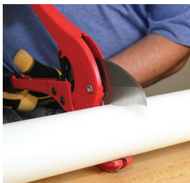
Figura 14: Cortar la tubería
