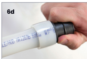
Figura 6: Introducción del accesorio ProPEX en la tubería PEX de Uponor de 1"
