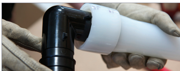
Figura 27: Asegurar que la tubería y el anillo se coloquen contra el hombro del accesorio
