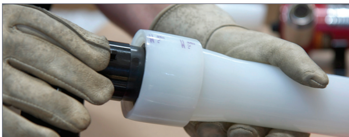
Figura 2-26: Introducir el accesorio
