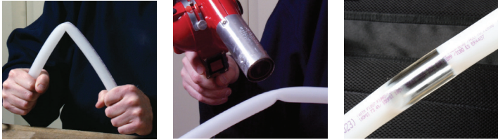
Figura 6-1: Reformar tubería torcida
