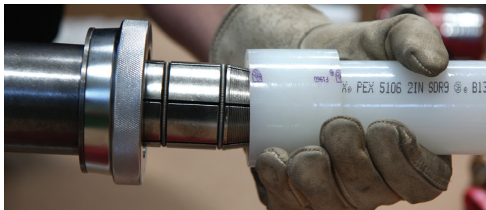
Figura 2-22: Deslizar el cabezal en la tubería
