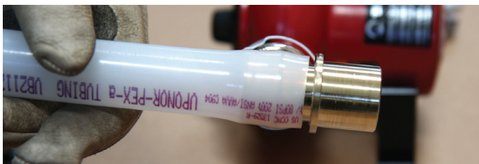
Figura 2-35: Calentar la conexión
