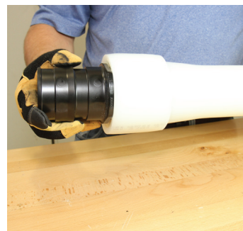
Figura 2-19: Introducir el accesorio
