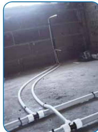
Figura 4. Instalação de aquecimento por radiadores com tubo Uponor Comfort Pipe PLUS, Uponor tes Q&E e com Uponor Smart Aqua joelho saída radiador Q&E.
