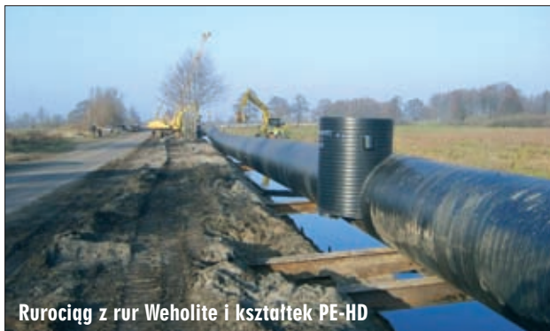
Zatapianie rurociągu
