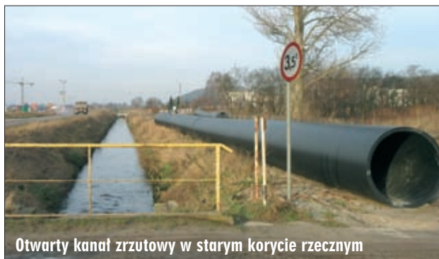
Rurociąg z rur Weholite umieszczony na kształtownikach stalowych
