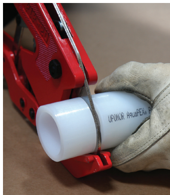
Figure 2-20 : Couper le tuyau
