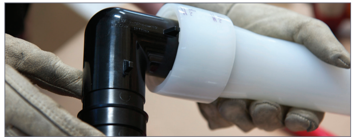
Figure 2-27 : S'assurer que le tuyau et la bague reposent contre la butée du raccord
