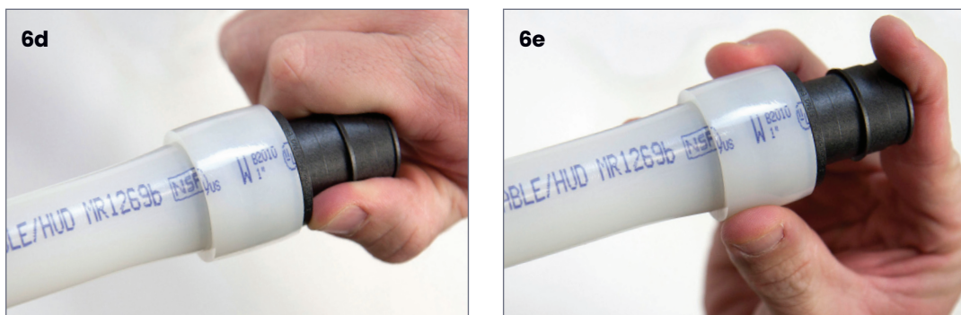
Figure 2-7 : Raccord ProPEX inséré dans un tuyau PEX de 1"
