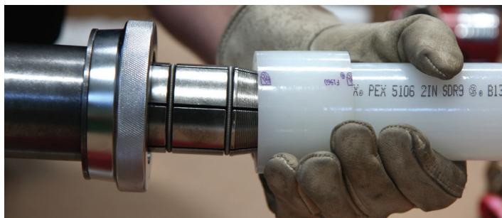
Figure 2-22 : Glisser la tête sur le tuyau
