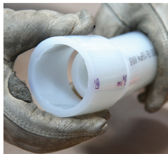
Figure 2-21 : Ajouter la bague
