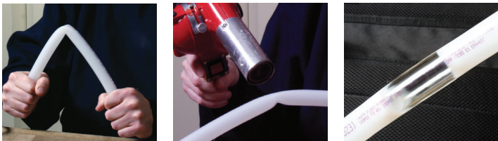
Figure 6-1 : Reformer un tuyau déformé
