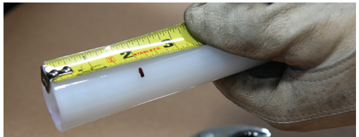
Figure 2-38 : Marquer l'extrémité du tuyau
