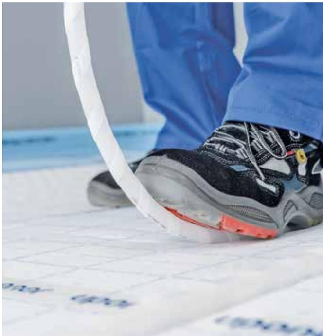
**Uponor Klett è un sistema innovativo di fissaggio delle tubazioni per il riscaldamento/raffrescamento radiante a pavimento. Le tubazioni sono rivestite con un nastro ad aggancio rapido avvolto a spirale. L'apposito foglio in tessuto è incollato sull'intera superficie del pannello dell'impianto. Quando il tubo viene premuto contro il pannello viene fissato nella posizione desiderata, il nastro delle tubazioni si aggancia alla lamina adesiva del pannello assicurando la massima forza di tenuta.**
