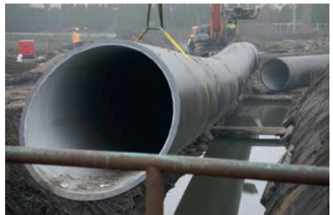
Montaż 50-metrowego odcinka z dospawanym łukiem
