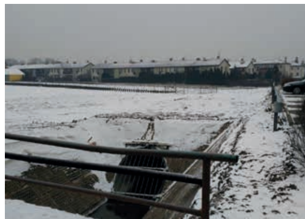
Zakończenie prac. Teren przeznaczony do rekultywacji, fot. D. Softys
