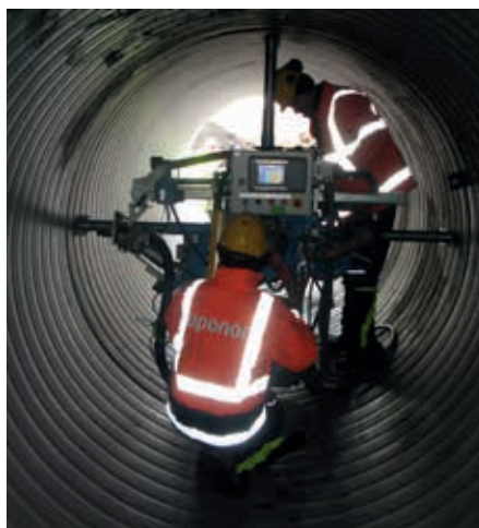
Spawanie ekstruzyjne maszyną WLI-3000
