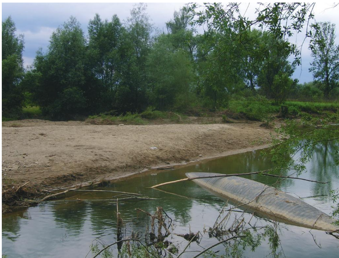
Fot. 1. Kolektor dosyłowy PE do oczyszczalni ścieków w Nowym Sączu DN1400 (3,4 km) podczas powodzi w 2010 roku. Rok budowy 1995
