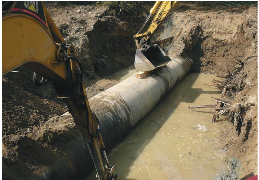
Fot. 2. Ponowne posadowienie kolektora PE DN1400 w Nowym Sączu po ustąpieniu powodzi
