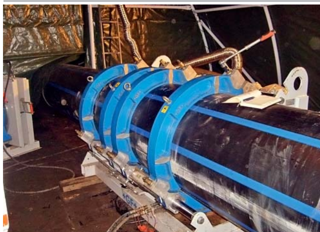
Fot. 3. Próbné zgrzewy w hali namiotowej
