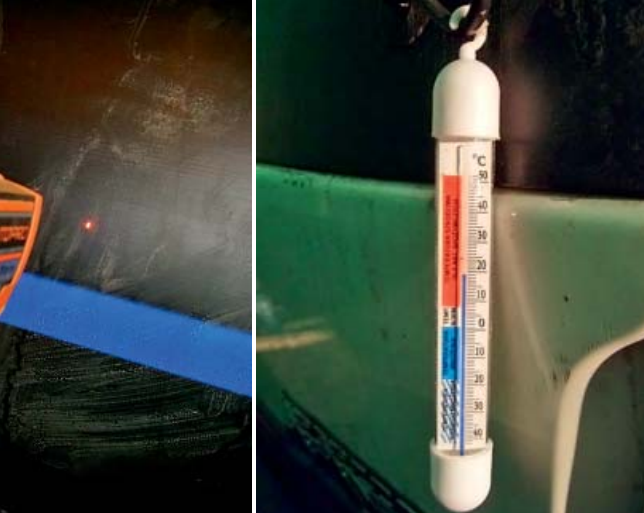
Fot. 6, 7. Pomiary temperatur rury i otoczenia – istotne parametry procesu zgrzewania
