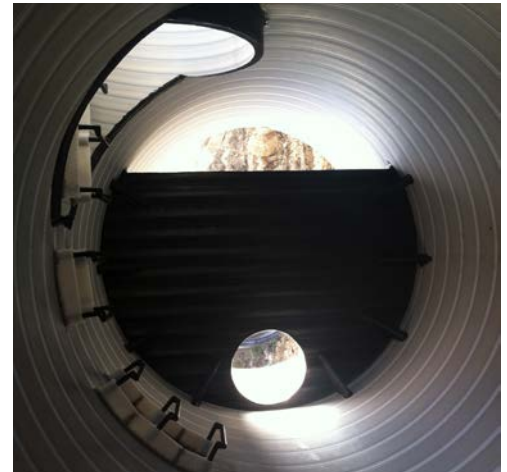
Wnętrze retencyjnego kanału ściekowego z przegrodą piętrzącą
