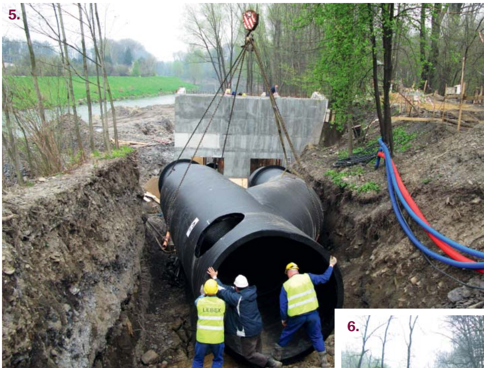
Fot. 5. Instalacja kształtki specjalnej tzw. „portek”
