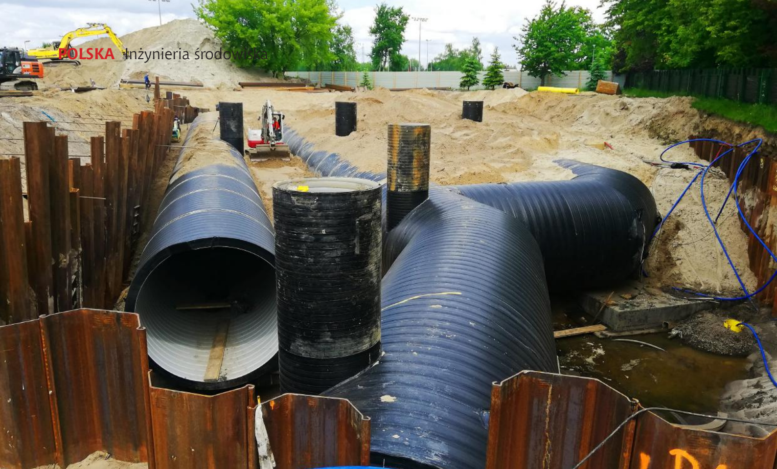
II etap inwestycji – zbiornik Weho SN8 DN 3000 wraz z łukami i trójnikami DN 3000
