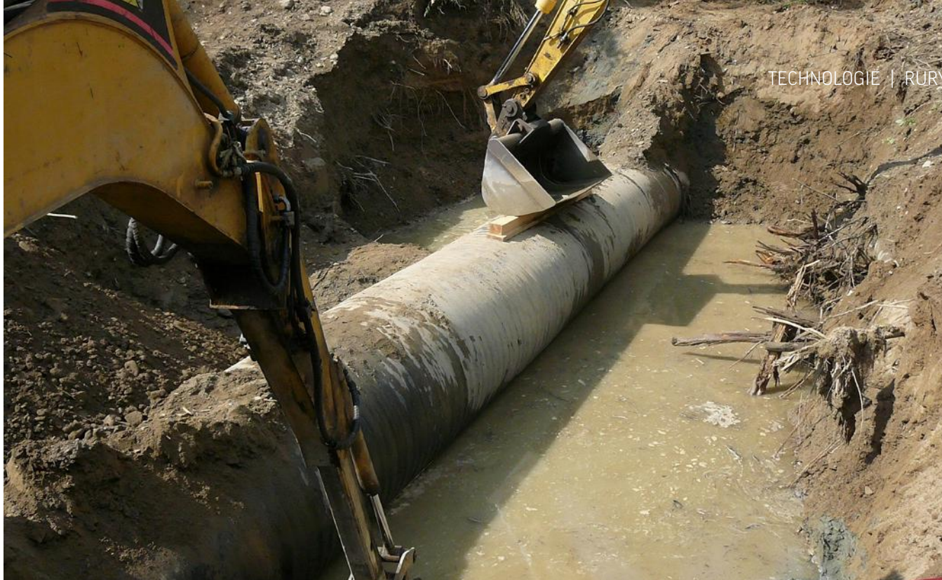
Ryc. 3. Ponowne posadowienie kolektora PE DN 1400 w Nowym Sączu po ustąpieniu powodzi, fot. K. Kudlik [7]
