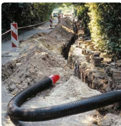
Brza i jednostavna ugradnja uz cigleni zid do glavnog razdjelnika
