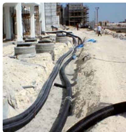
Mreža rashladnog sustava s cijevima Uponor Supra u Bahreinu
