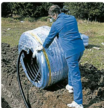
Prilagođena dostava na gradilište; izravna ugradnja iz koluta
