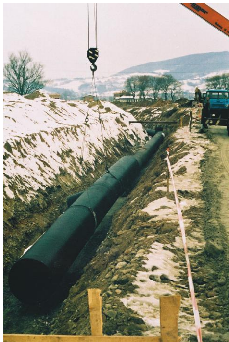
Fot. 1. Nowy Sącz 1995, kolektor grawitacyjny PEHD Weholite DN1400
