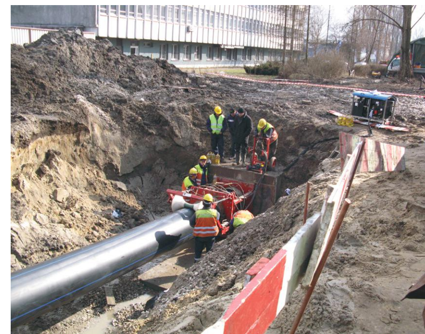
Fot. 2. Łódź 2008, instalacja rur WehoPipe PE100 DN800 metodą ciasnopasowaną
