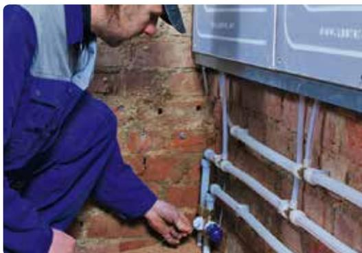
Esempio: connessioni di pannelli Uponor Renovis montati sulla parete. Singolo locale controllato da termostato ambiente.
