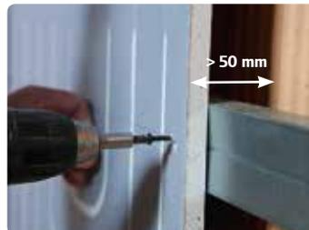
Esempio: sottostruttura con profili metallici CD 27/60
