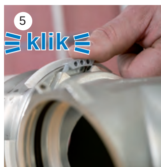
Kuva 1. Asenna viistetty komposiittiputki Uponor RS-liitinjärjestelmän puristuspäähän.
