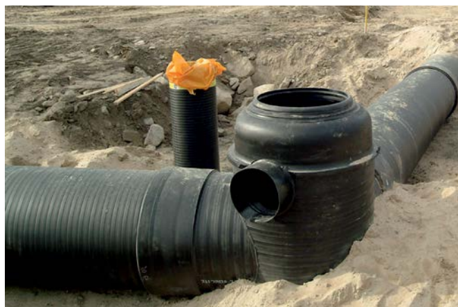
Ilmajoki, Финляндия: Общая длина коллектора сточных вод от свалки превышает 2550 м и состоит из труб Weholite DN/ID 600 мм и DN/ID 700 мм, класс жесткости SN4.
