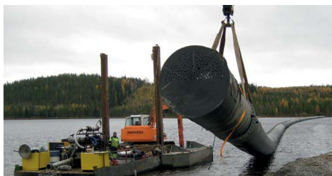
Рудник Talvivaara, Sotkamo, Финляндия: «Упонор» погрузил трубу Weholite DN/ID 1600 мм длиной 250 м для забора сырой воды.
