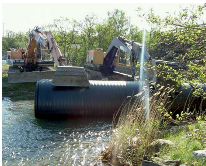
Åvabro, Аландские острова: Старая стальная гофрированная водопропускная труба под дорогой была заменена путем протаскивания трубы Weholite DN/ID 1600 мм SN4 общей протяженностью 30 м.
