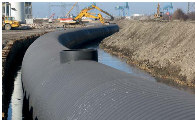
Fos-sur-Mer, Франция: Weholite относится к числу тех редких труб на мировом рынке, которые можно приобретать диаметром свыше DN/ID 2000 мм.
