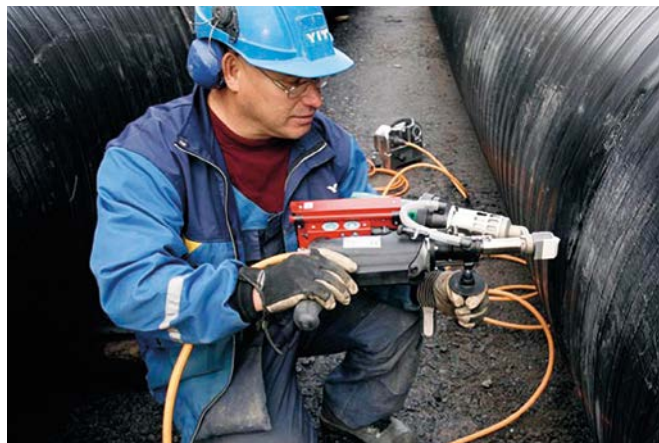
Ручной экструдер. Сварка ручным экструдером особо хорошо применим для уплотнения водонепроницаемых резьбовых соединений.
