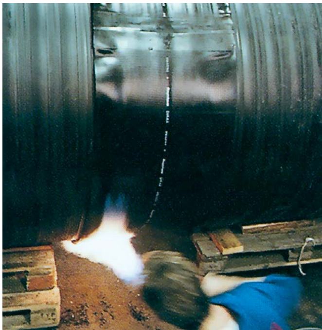
Уплотнение трубы термоусадочной лентой
