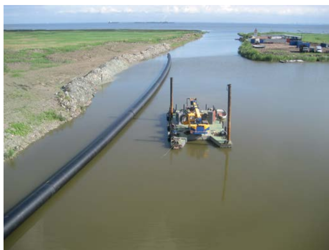
Санкт-Петербург, Россия: Выпускная труба очистного сооружения. Для данного проекта «Упонор» поставил 1060 м трубы DN/ID 1200 мм и предоставил услуги по сварке.
