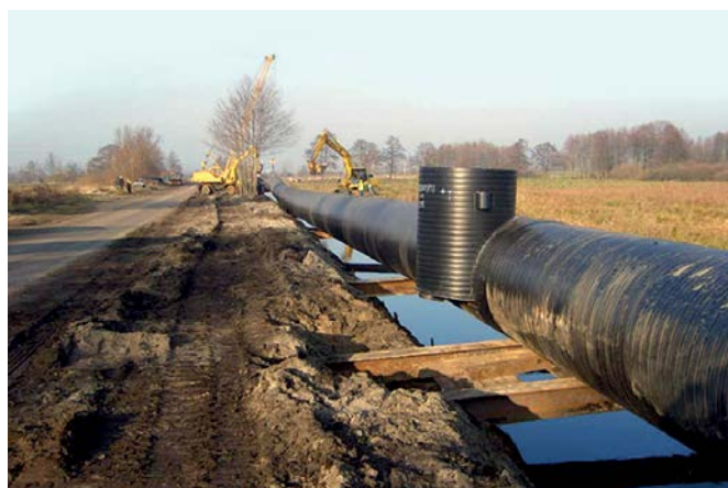
Gdynia, Польша: «Упонор» поставил трубы Weholite DN/ID 1400-1500 мм и 22 колодца для выпускных труб очистного сооружения. Большинство труб для установки сооружения были поставлены отрезками длиной 15 м.
