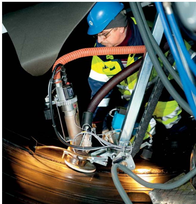
Машина для внутренней экструзионной сварки. Вся работа должна выполняться обученным, опытным персоналом.
