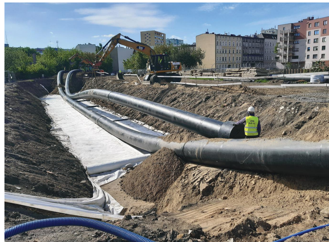
Fot. 2. Szczecin 2020 r. Przekładka rurociągu PE WehoPipe DN800
