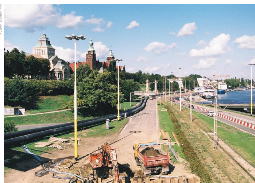
Fot. 1. Szczecin 2007 r., zgrane rurociągi przygotowane do wciągnięcia do przewiertu pod rz. Odrą
