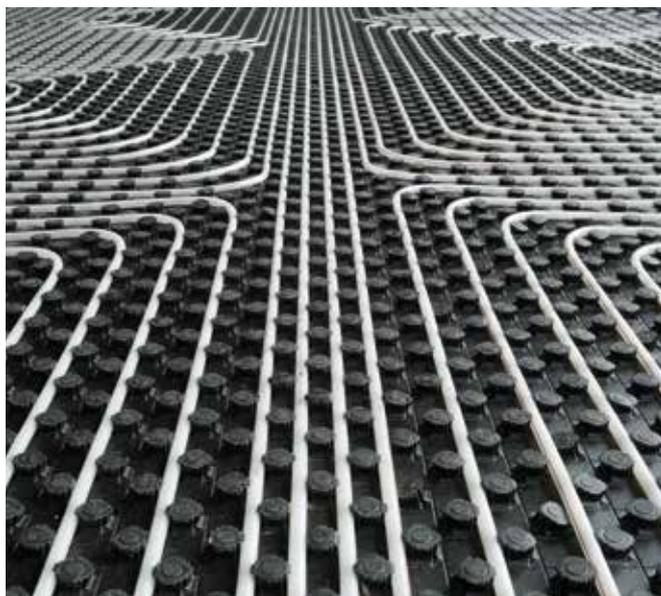
Il sistema radiante ad umido Uponor Tecto può essere posato da una sola persona. Le dimensioni dei pannelli sagomati di 1.450 x 850 mm assicurano elevate prestazioni di posa.
