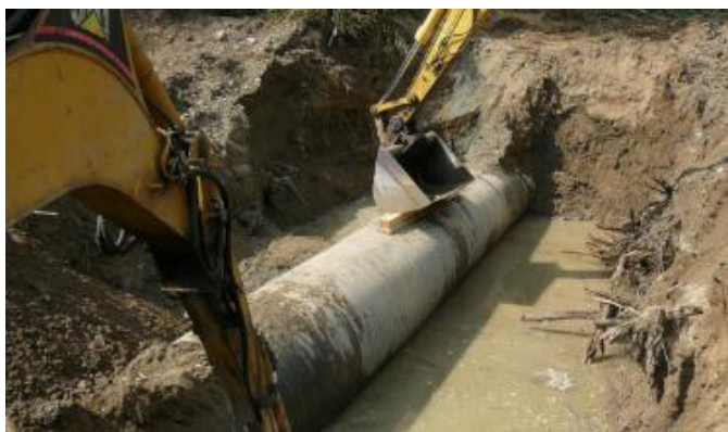
Rys. 2. Ponowne posadowienie kolektora PE DN1400 w Nowym Sączu po ustąpieniu powodzi (fot. Kazimierz Kudlik) [7]
