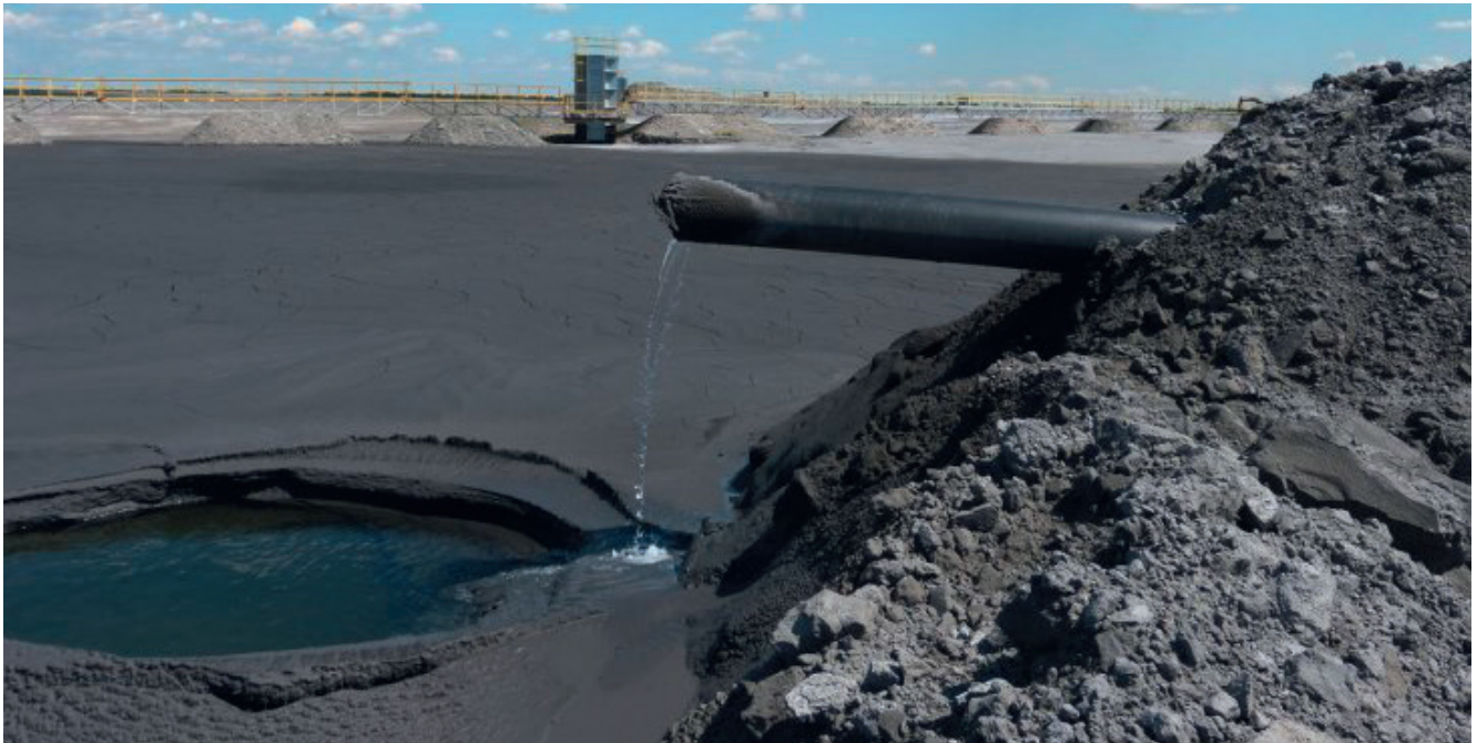
Hydrotransport popiołów na składowisku Elektrowni Bełchatów. Fot. Uponor Infra sp. z o.o.
