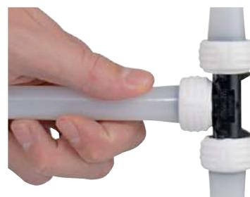
3 - Glissez le tube élargi sur le raccord. Tenez brièvement jusqu'à ce que le tube se rétracte
