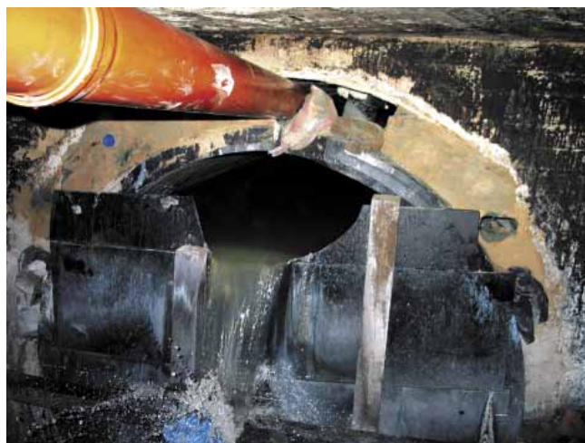
Fot. 2. Napeliony rurociąg SPIRO podczas iniekcji
