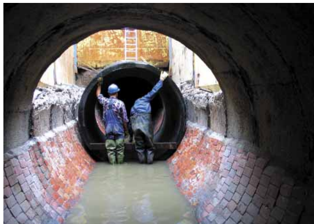
Fot. 4. Wkładanie rury SPIRO
