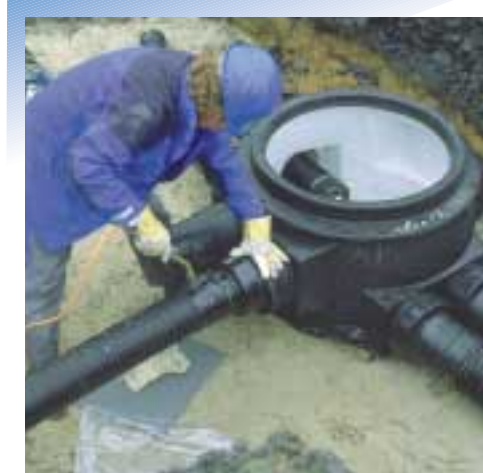
Peale otsakatete ja liitmike paigaldamist tihendatakse kaevuliitmik kuumaheneva sukaga.
