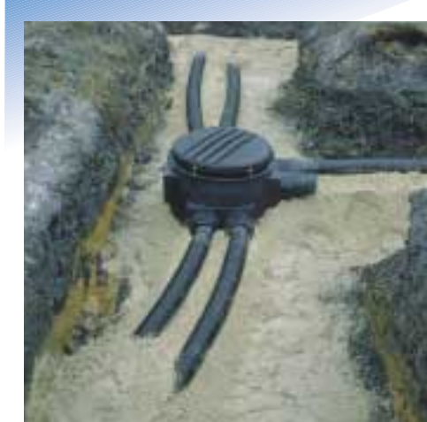
Kogu süsteemi hea töö tagatiseks on täitepinnase korralik tihendamine.
