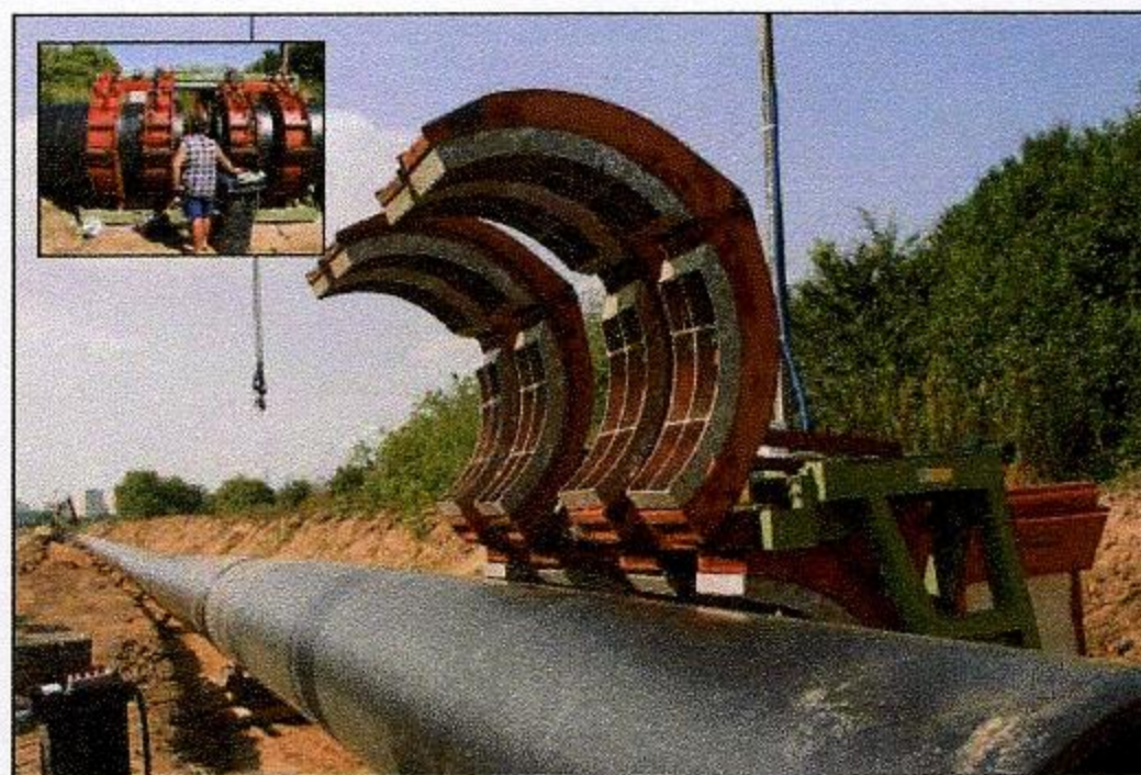
Fot. 3 Łączenie rur WehoPipe
