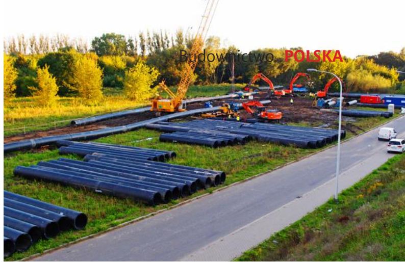
Rury zdemontowane z układu tymczasowego pracującego w 2019 r. przed ponownym użyciem w 2020 r.
