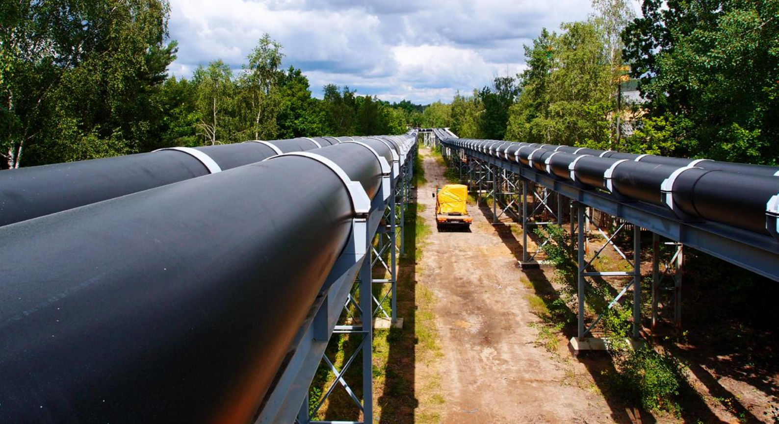
KGHM Polska Miedź S.A. – wykorzystanie rurociągów PE-HD do transportu odpadów popłytacyjnych
