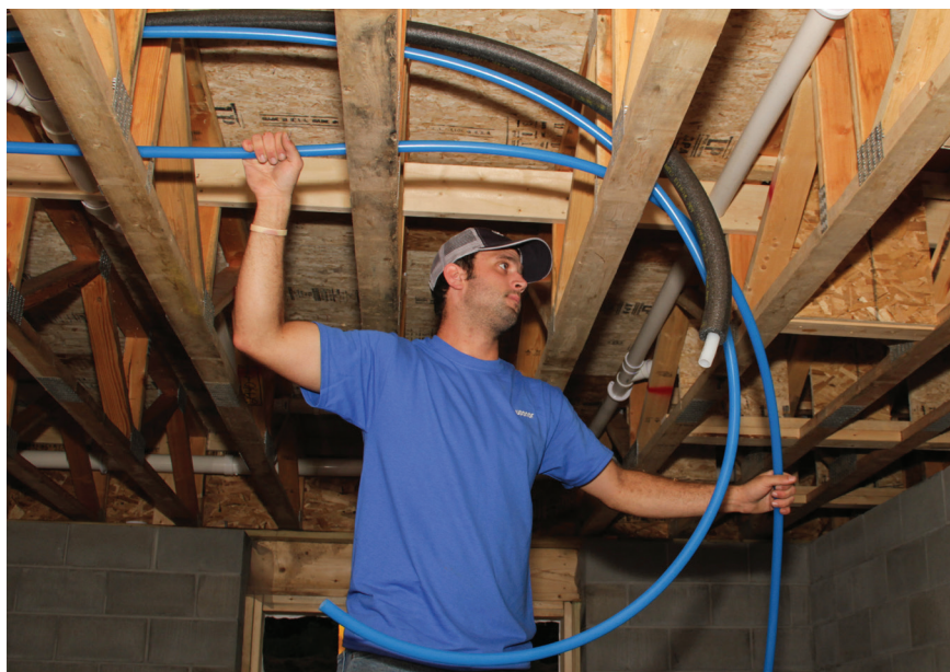
Figura 6-1: Tramos principales de AquaPEX de Uponor pasando por entramados con armazón abierto
