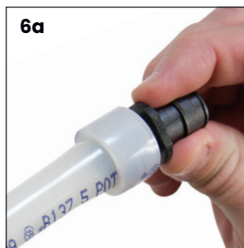
Figura 3-4: Introducción del accesorio ProPEX en la tubería PEX de Udonor de ½"
