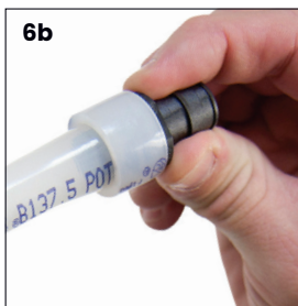
Figura 3-4: Introducción del accesorio ProPEX en la tubería PEX de Udonor de ½"
