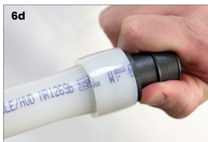
Figura 3-5: Introducción del accesorio ProPEX en la tubería PEX de Udonor de 1"
