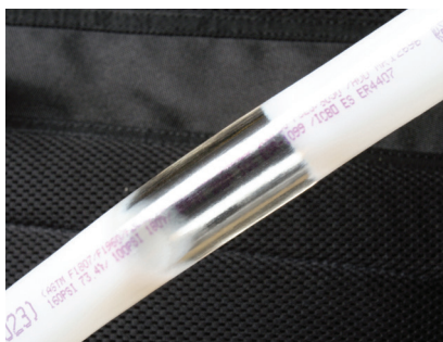
Figura C-1: Reformar tubería torcida
