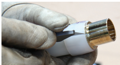
Figura 3-22: Cortar el anillo
