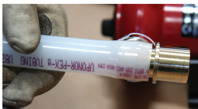
Figura 3-24: Calentar la conexión
