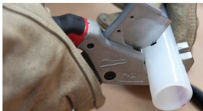
Figura 3-28: Cortar la tubería en la posición indicada
