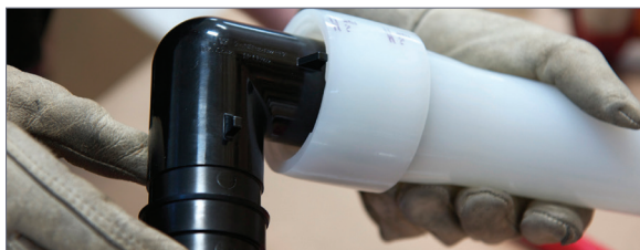
Figure 27 : S'assurer que le tuyau et la bague reposent contre l'épaule du raccord
