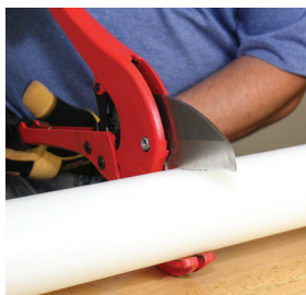
Figure 14 : Couper le tuyau
