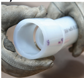
Figure 21 : Ajouter la bague
