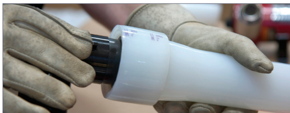
Figure 26 : Insérer le raccord
