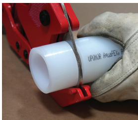
Figure 20 : Couper le tuyau
