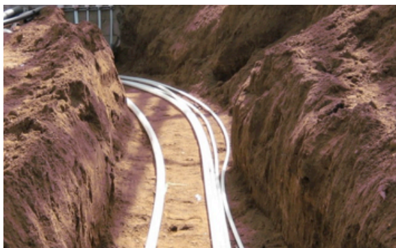
Figure 79 : PEX Uponor sous le niveau du sol
