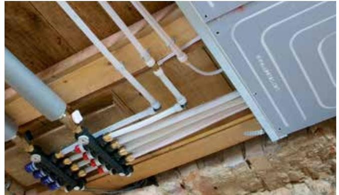
Beispiel: Anschluss der Uponor Renovis Panels in der Decke an einen Uponor Vario PLUS Verteiler, Einzelraumregelung über thermische Stellantriebe und Smatrix Raumfühler.
