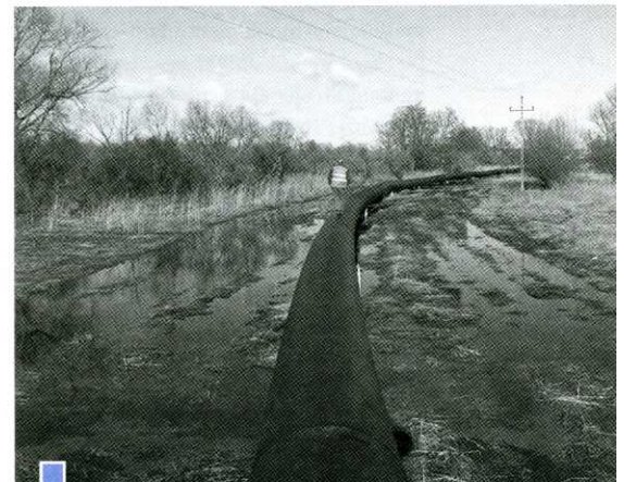
Fot. 3. Rurociąg po procesie zgrzewania
