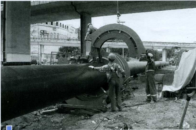
Fot. 2. Zgrzewanie rur PE 1033
