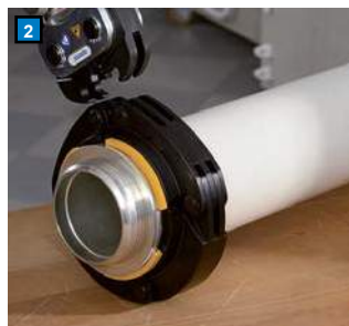
Presning Pres samlingen ved hjælp af preskæden og tilhørende presværktøj.
