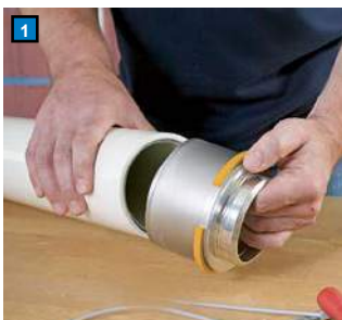
Fastgør presadapter Stik det kalibrerede rør i indstiksmuffen på presadapteren
