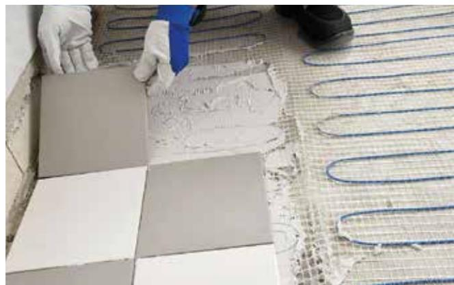
Anschließend können die Fliesen mit Fliesenkleber auf dem Heizsystem verlegt werden. Uponor Comfort E ist sofort nach dem Trocknen und Verfugen einsatzbereit und erzeugt wohlige Wärme auf dem Fußboden.
