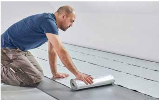
Im Trockenbau werden die Uponor Comfort E Aluminium-folie-Heizmatten ausgerollt. Optionale Dämmplatten schützen die Mattenunterseite vor Beschädigung und reduzieren die Wärmeverluste nach unten.
