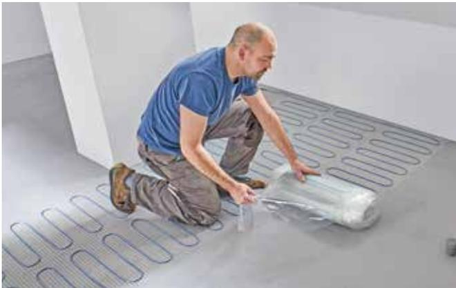
Die Verlegung von Uponor Comfort E ist denkbar einfach – die Matten werden auf dem vorbereiteten Untergrund einfach ausgerollt. Dabei sorgt die selbstklebende Unterseite der Kabelmatten für einen festen Verbund zum Untergrund.
