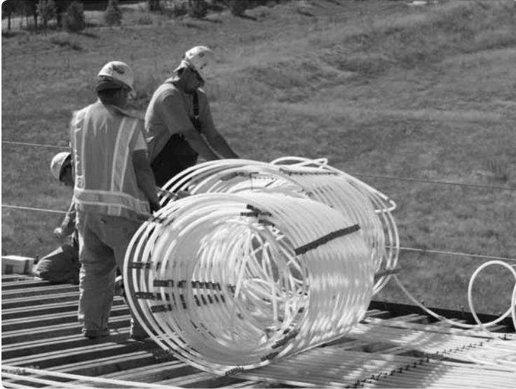
pas de climatisation. Par contre, on pourrait faire exception pour une salle de bains intérieure avec plancher en tuiles. L'installation de tuyaux améliorera le confort là où le plancher pourrait être trop froid.
