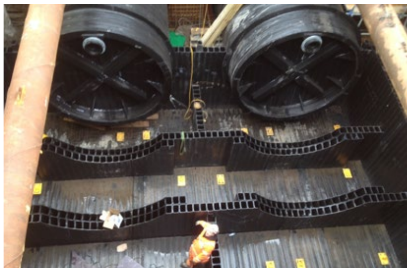
Montaż komór z użyciem rur i paneli PE-HD Weholite
